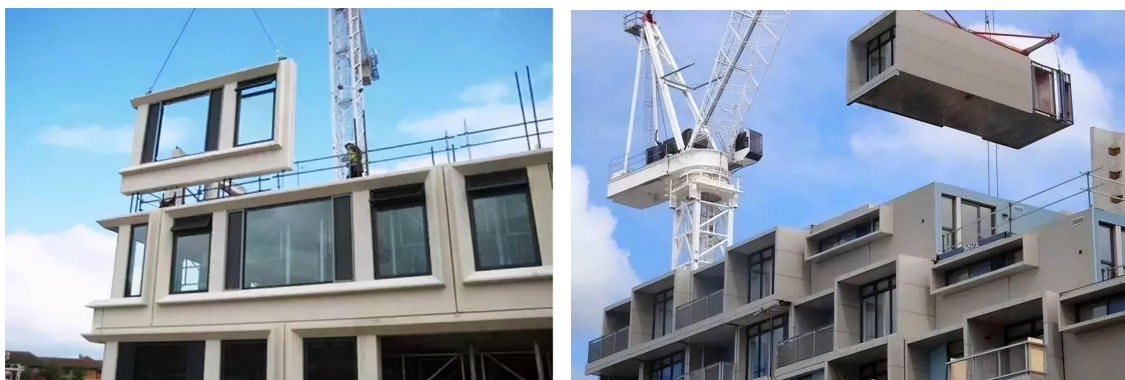
图 1 装配式建筑实例
